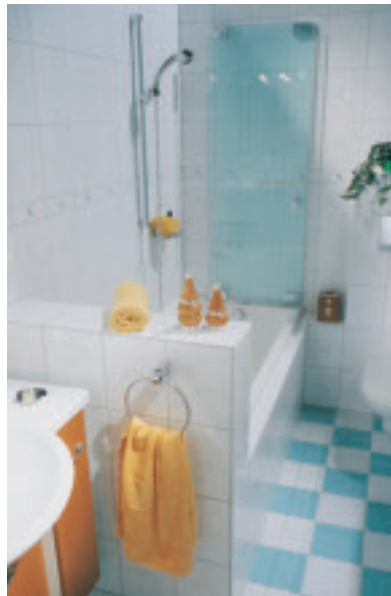
La dimension de la trappe parfaitement adaptée à celle des carreaux la rend quasi invisible.
